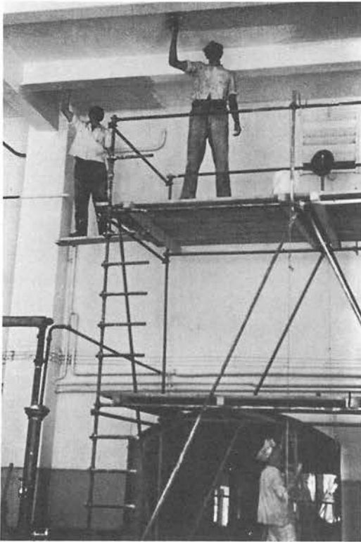
Malerarbeiten in der Küche
