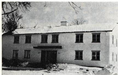
Hovedbygningen på Trossnäs.
